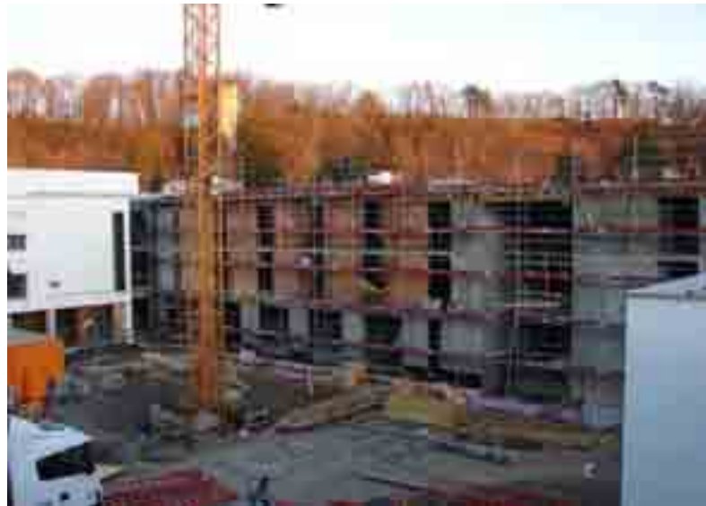
Bau neues AWO Zentrum
